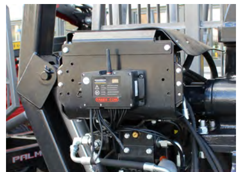
Empfänger des Scanreco-Funksystemes am Steuerblock
